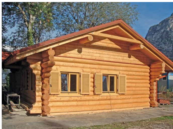
SRUB S PERFEKTNĚ PROVEDENÝM NÁTĚREM
