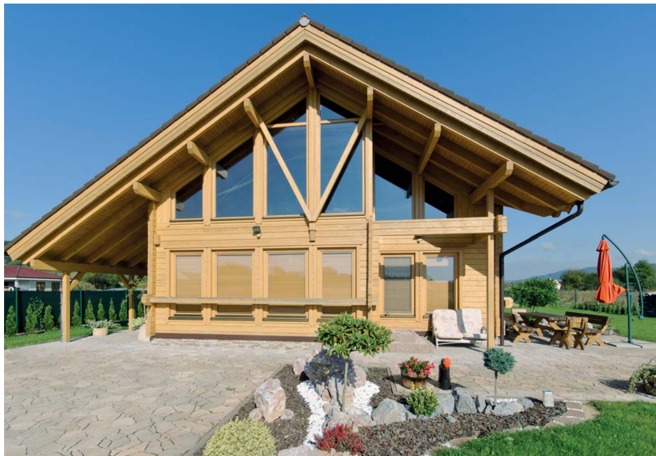
Srubový dům s prosklenými štíty, konstrukce z lepených hranolů, užitná plocha 168 m 2
