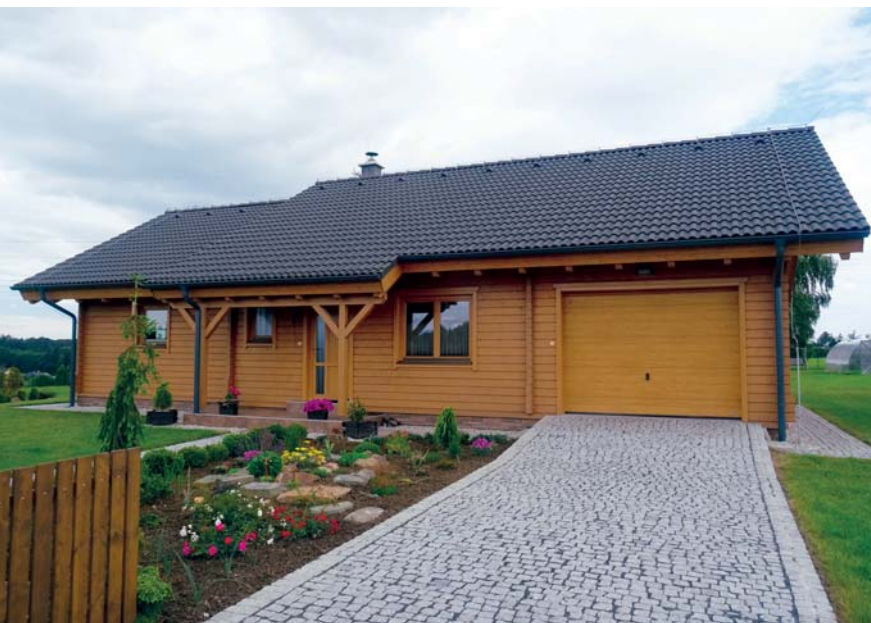
Přízemní srubový dům 3 + kk, užitná plocha 110 m 2 , srubová konstrukce z lepených hranolů s dřevěnou izolací a obkladem
