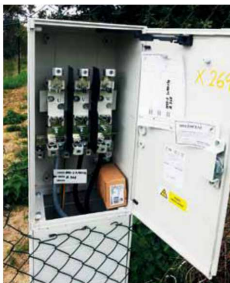
Pojistková skříň poskytovatele elektřiny
