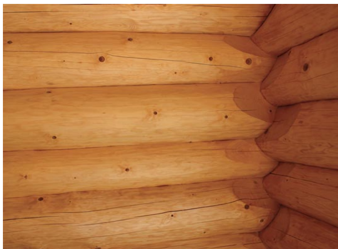
SPRÁVNĚ DOSEDNUTÁ STAVBA
