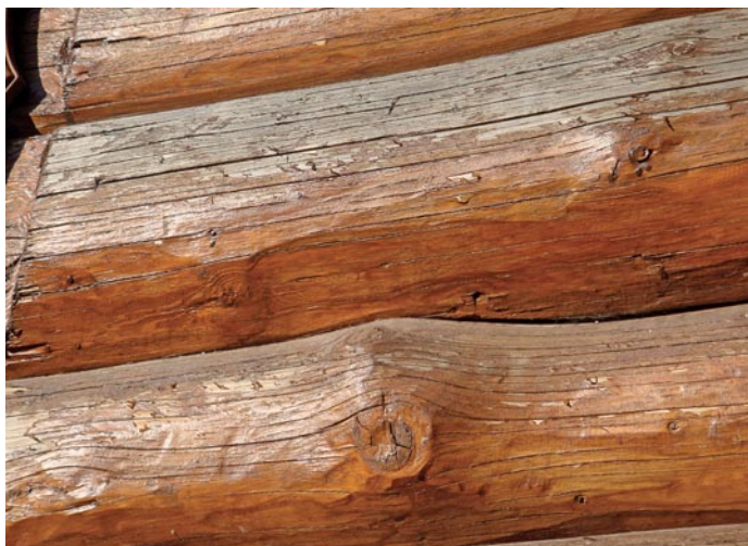
NÁTĚR STAVBY SE NESMÍ ZANEDBAT, O ČEMŽ SVĚDČÍ STĚNA SRUBU, KTERÝ NEBYL NATŘENÝ VÍCE NEŽ ŠEST LET
