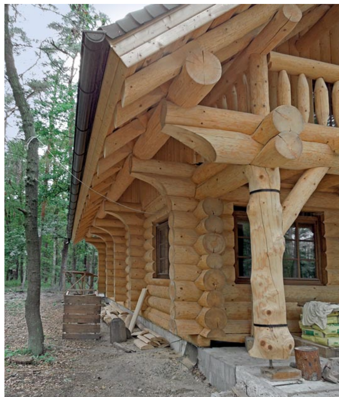
NOSNÝ SLOUP S REKTIFIKAČNÍM ŠROUBEM. NĚKTERÉ SLOUPY JE TŘEBA POVOLAVAT MĚNĚ, JINÉ VÍCE
